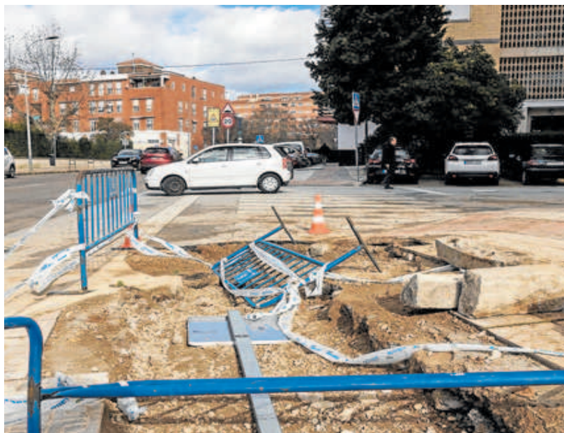
Vallas en una de las zanjas abiertas en la avenida Augusto Vázquez. ÁNGEL MÁRQUEZ
